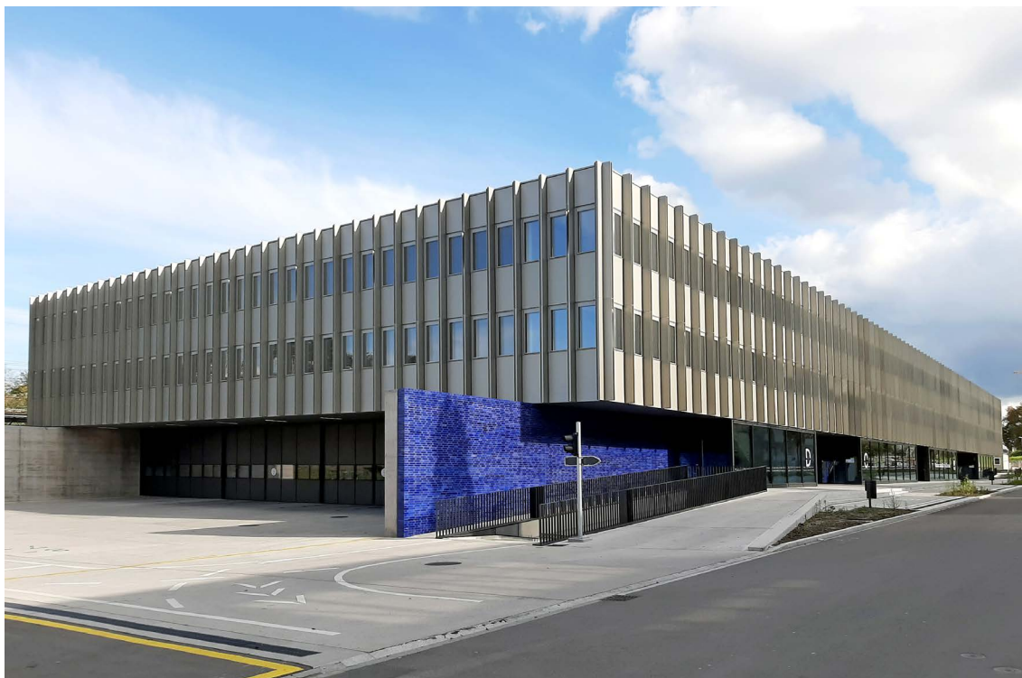
Vue du dépôt de bus et de l'école avec deux salles de sport
