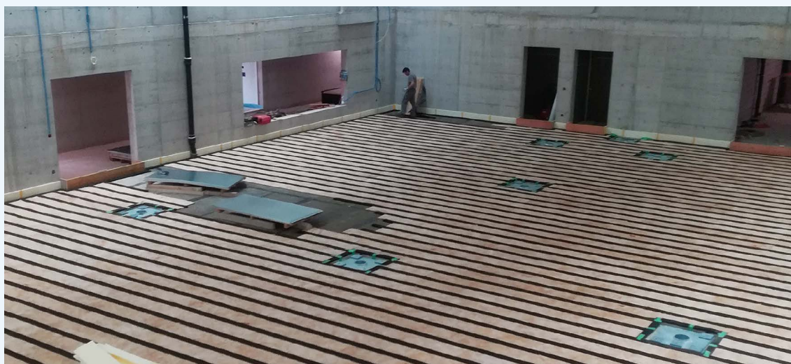
Appui avec bande en ISOLMER® avec amortissement des cavités, ISOLMIN® et douilles de sol.
