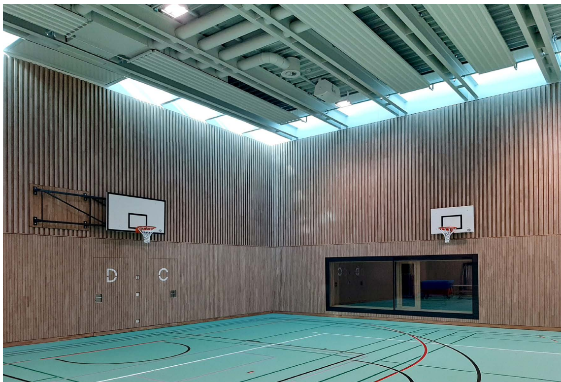
Contre-cloisons en bois
