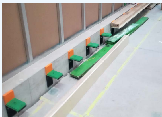
Supports amortissant les bruits de structure pour la fixation du vitrage fixe
