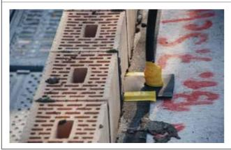
**4** Tous les percements de tuyaux doivent être rendus étanches conformément à l'étape 1-3 avec de l'ISOLINE-SPEEDY. Ensuite monter le mur sur l'appui de séparation acoustique ISONOVA.
