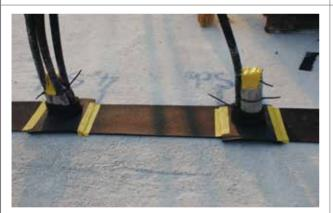
**3** Les recouvrements au niveau de la plaque d'appui et de l'appui de séparation acoustique ISONOVA doivent être collés de manière étanche avec de la bande adhésive à béton.
