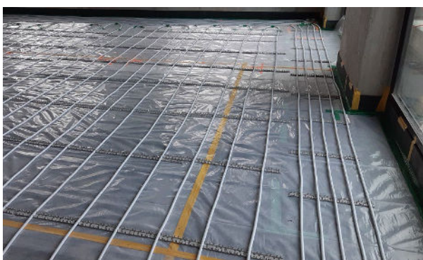
Variante mit Bodenheizung vor Eintrag des Unterlagsbodens (Estrich). Durch die schwache Einfederung des Materials eignet sich auch die Verlegung der Bodenheizung.
