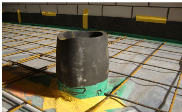
Rohrakkopplungen bei Durchbrüchen und Erstellen der Bewehrung vor Eintrag der Beton-Lastverteilplatte.
