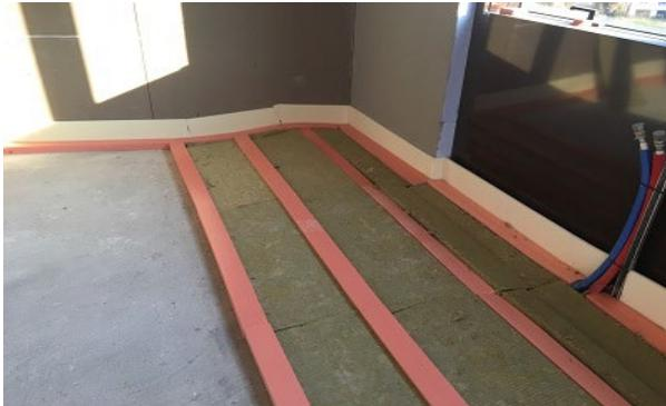
*Die ISOLMER®-Streifenlagerung werden in Kombination einer Hohlraumbedämpfung gemäss Vorgaben und Anforderungen durch die HBT-ISOL Monteure verlegt*
