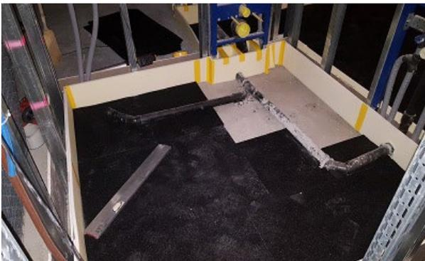
*Der ganze Sanitär- und Garderobenbereich, wird aufgrund der Anforderungsparameter vollflächig über Elastomerkormatten gelagert*
