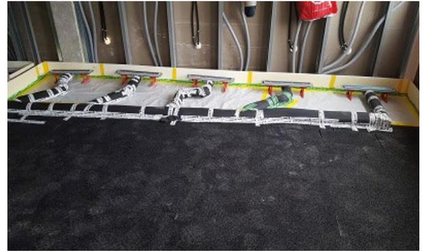
*Sämtliche Leitungen und Leitungsdurchdringungen die in oder durch den Unterlagsboden geführt werden, müssen zusätzlich abgekoppelt werden*
