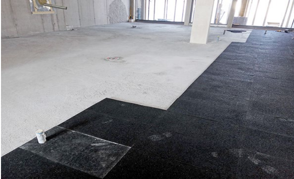
Exaktes Verlegen der 30 mm dicken, hochwertigen, gerillten Dämmplatten des Typs ISOPOL® 112-30-14
