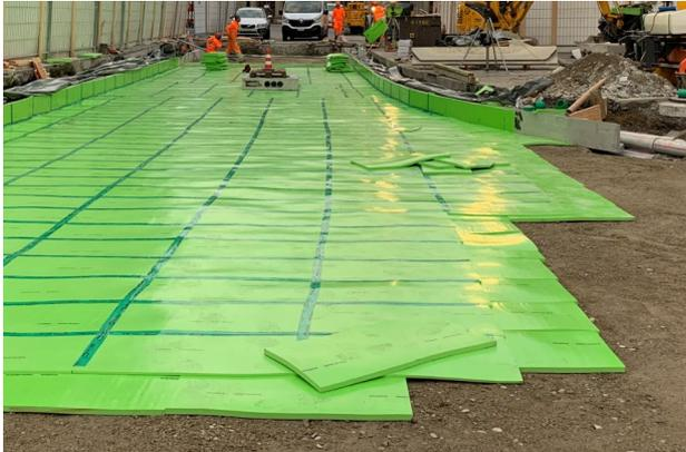
Die Betonplatte des Tramtroges wird auf Dämm-Matten Typ ISOLMER® elastisch gelagert. Die Matten werden satt gestossen auf die Planie des Unterbaus verlegt bzw. vertikal an die Winkelelemente angeklebt.
