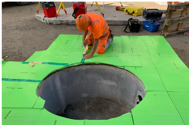
Die Schutzrohre verschiedener Leitungen werden über Kontrollschächte im Bereich des Tramtroges geführt. Die ISOLMER® Matten werden bis zum Ring des Kontrollschachtes geführt und exakt eingepasst.
