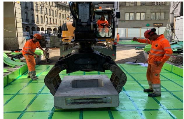
Versetzen des Abschluss-Elementes über dem Kontrollschacht. Das Element wird auf den ISOLMER® Dämm-Matten aufgelegt und wird über eine Anschlussbewehrung kraftschlüssig mit dem in einer späteren Phase betonierten Tramtroge verbunden.
