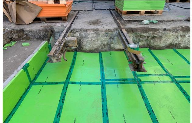
Anschluss der Dämm-Matten an die Dämmung des bestehenden Tramtroges. Alle Mattenstösse werden mit einem Klebeband abgedichtet. Anstelle des Klebebandes kann diese Abdichtung auch mit vollflächiger, dicht verklebter PE-Folie ausgeführt werden.
