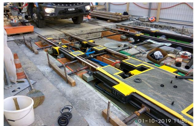
Montage der Geleise und der Anbauteile auf dem Schutzbeton über den ISOLMER® Dämm-Matten. In einem nächsten Schritt wird der Tramtroge ausbetoniert.
