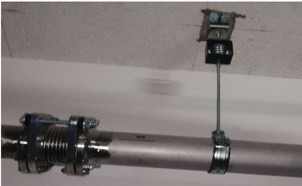
Beispiel eines montierten ISOROHR® -Elements zur Decke, welches spezifisch auf die Last dimensioniert und montiert wurde
