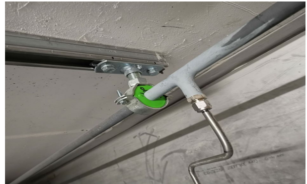
Beispiel einer wirksamen, körperschalldämmenden Trennung mittels einer montierten ISOSCHELL Rohrschelle, welche spezifisch auf den Durchmesser und die Belastung dimensioniert wurde
