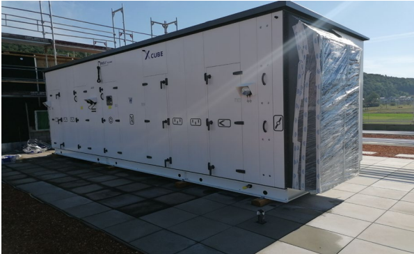
Die Kältemaschinen und der Monoblock werden am definitiven Standort provisorisch auf Hölzer platziert
