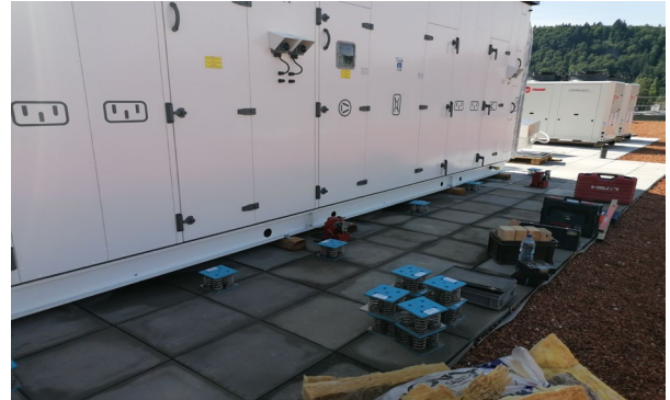
Die vordimensionierten Federpakete werden bereitgestellt
