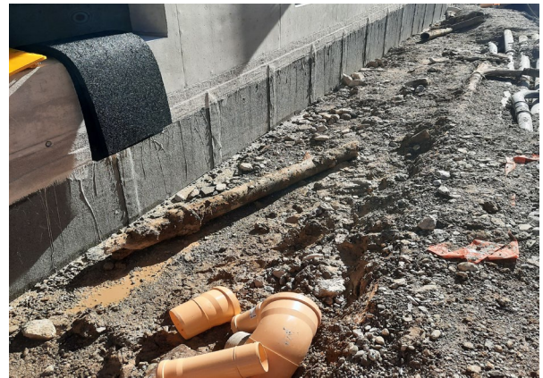
Abdichtung der bestehenden Gebäude. Auf die Höhe der Kofferrung wurde als Entkopplungsmatte das ISOPOL® eingebaut
