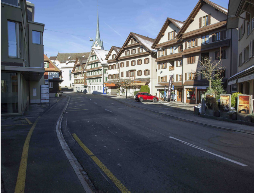
Dorf Menzingen mit schmaler Strasse kurz vor dem Beginn des Bauvorhabens Quelle: www. https://www.zg.ch/behoerden/baudirektion/tiefbauamt/aktuelle-projekte/optimierung-der-ortsdurchfahrt-menzigen
