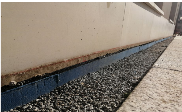
Sichtbare Entkopplungsmatte nach dem Erstellen des Strassenaufbaus. Nach Einbau des Endbelages wird diese nicht mehr sichtbar sein
