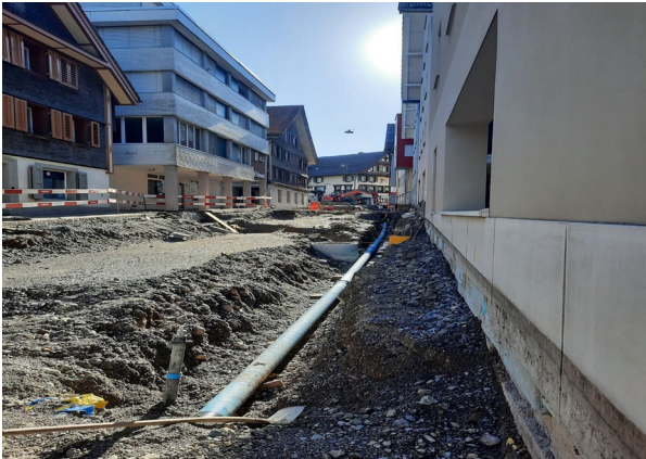
Bild der Bauarbeiten mit Werkleitungen
