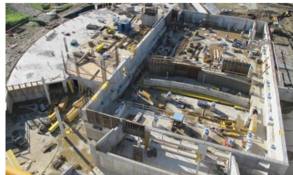
Übersicht über die gesamte Baustelle mit versetzten Stahlfederelementen. Im Vordergrund sichtbar die Vertiefung für den Orchestergraben
