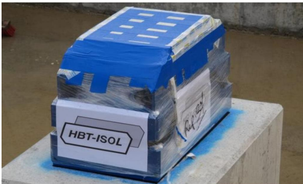
Präzise positioniertes, vorgespanntes Stahlfederelemente des Typs ISO FED®-G. Eingepackt zum Schutz bis zur Lösung der Vorspannung
