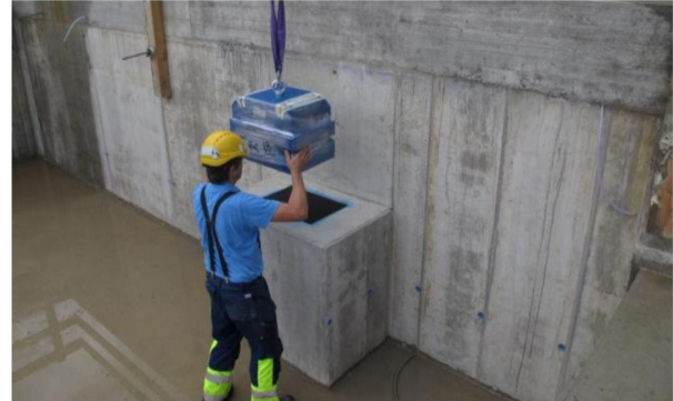
Versetzen der ersten Stahlfederelemente des Typs ISO FED®-G. Dieses Element zum restlichen Gebäude / Erdreich verhindert, dass die vom Bahnverkehr verursachten Schwingungen und Erschütterungen direkt in den Konzertsaal eingeleitet werden
