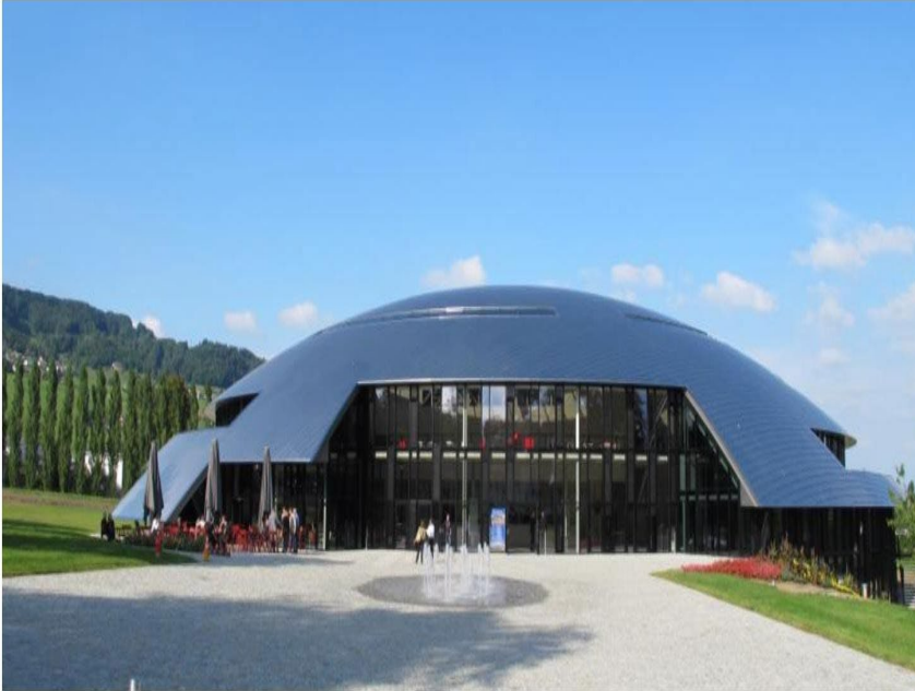
Le Rosey – Carnal Hall: Konzertsaal in Nähe Bahnlinie auf Stahlfederelementen gelagert
