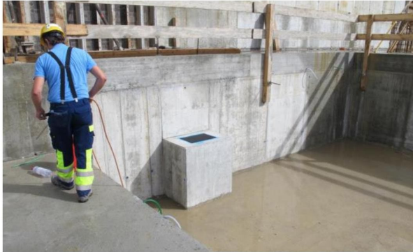
Erstelltes Gebäudefundament mit vorbereiteten Betonsockel für das Versetzen der Stahlfederelement
