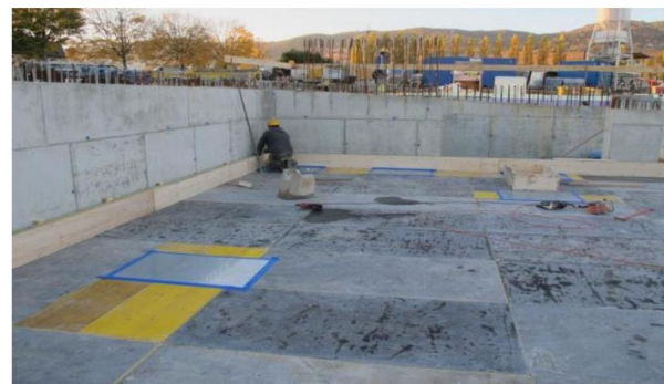
Planebene, vorbereitete Schalungsfläche zum Verlegen der Bewehrung und anschliessendem Betonieren
