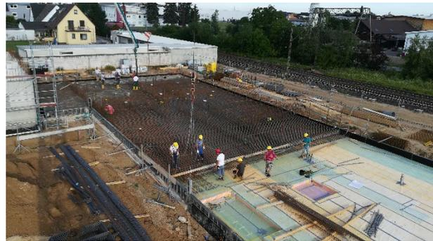
Im unteren rechten Bildrand ist die fertig verlegte Erschütterungsdämmung ersichtlich, die mit einer PE-Folie vor Betonmilch geschützt wird. In der Bildmitte wurde bereits Bewehrung verlegt und durch die Qualitätssicherung von HBT-ISOL abgenommen. Am oberen linken Bildrand beginnen die Fachkräfte der Baufirma mit dem Einbringen des Betons.
