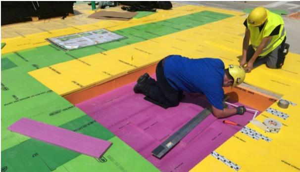
Nach der Erstellung eines korrekten Magerbetons kann mit der plangenaunen Verlegung der ISOLDYN® Matten begonnen werden.
