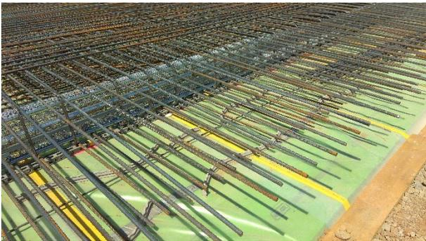
Um einen schallbrückenfreien Übergang zwischen den Etappen sicherzustellen, wird in Absprache mit der Baufirma festgelegt, wie die Übergänge auszugestalten sind.
