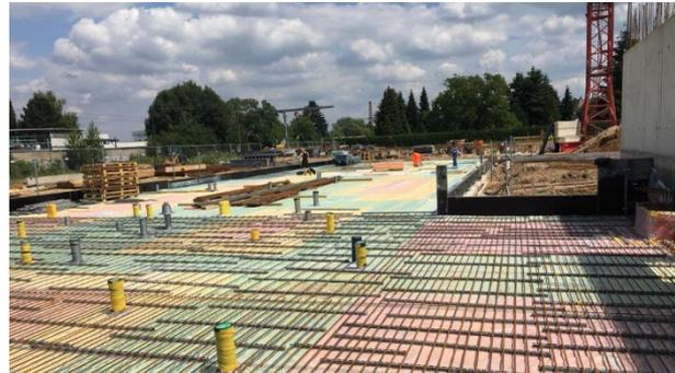
Nachdem eine Teilfläche mit elastischen Lagern verlegt ist und Rohre ummantelt sind, beginnen nachfolgende Gewerke (Bewehrung, Sanitär- und Elektroinstallation) mit ihrer Verlegung.
