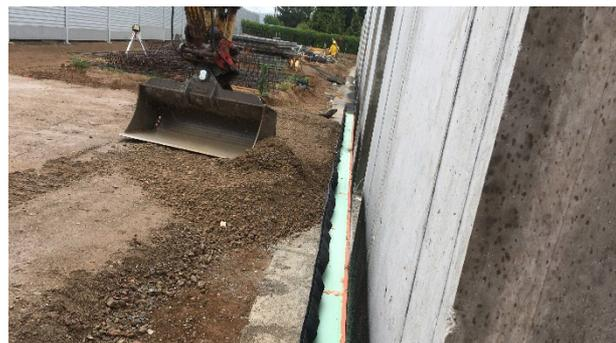
Nach dem Verlegen der vertikalen Schalldämmmatten, der Wärmedämmung und der Noppenfolie wird umgehend hinterfüllt, um ein Verrutschen der Matten zu verhindern und so die Funktion zu garantieren.
