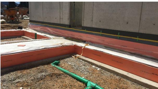
Vertiefungen und bahnzugewandte Wände müssen in der horizontalen sowie in der vertikalen vom Erdreich getrennt werden.
