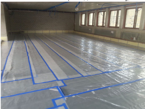
Fertige Flächenlagerung vor dem Bewehren
