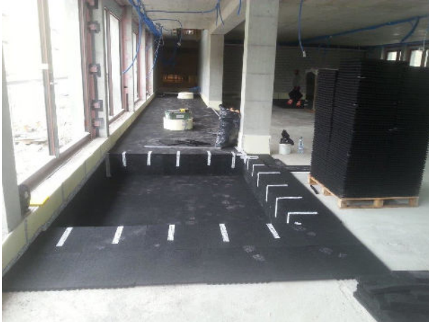
Prüfstrasse mit dauerelastischen Lager vom Typ ISOPOL®
