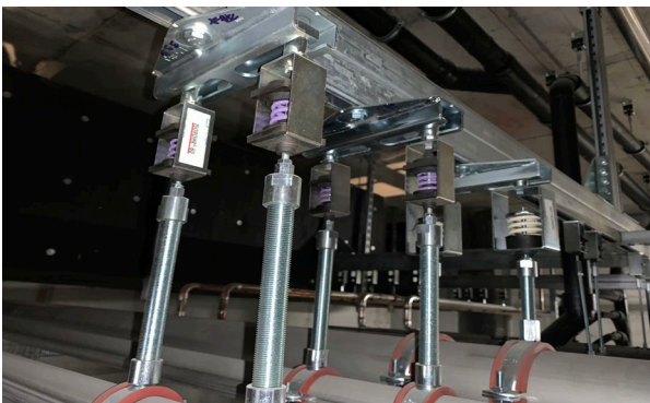
Beispiel von montierten ISOROHR®, welche jeweils nach Leitungs- als auch nach Lasttyp entsprechende spezifisch dimensioniert und montiert worden sind
