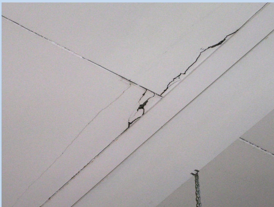
Decke vor der Lagerung
