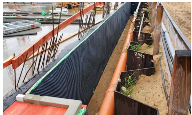
Abdeckung der Vertikallager vor dem Verfüllen mit ISONOPP-Lagerschutzmatten.
