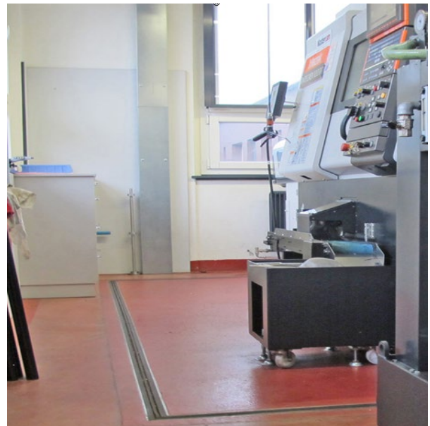
Fertig eingebaute Fugen-Abdichtung zwischen gelagerter Maschinen-Fundamentplatte und ungelagerter Decke
