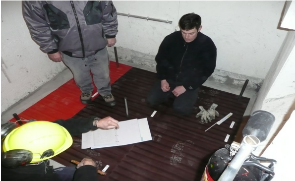
Verlegen und ausrichten der Körperschalldämmung
