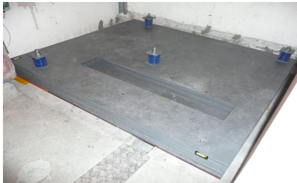
Lastverteilplatte und Massengewicht wird durch PUR-Lager-System übernommen.
