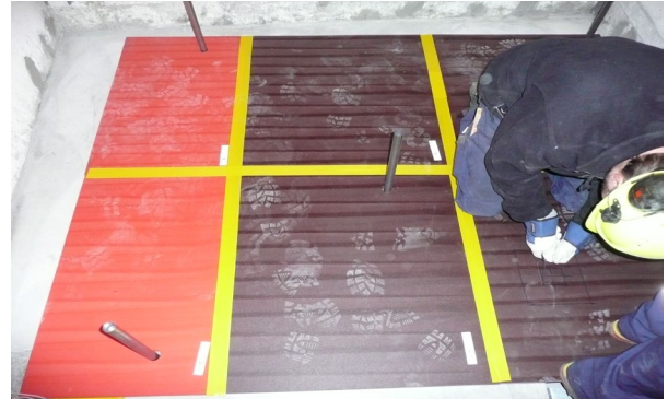
Vorbereiten der entkoppelten Unterkonstruktion für die Aufnahme der Lastverteilplatte
