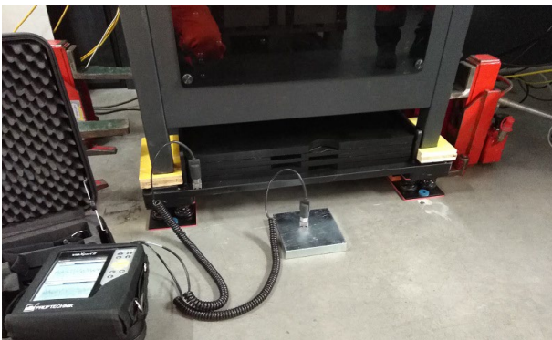
Schwingungsmessungen bei der Montage zur Überprüfung der Anforderungen
