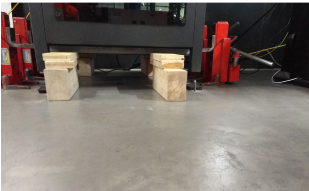
Fachgerechtes Anheben der Anlage
