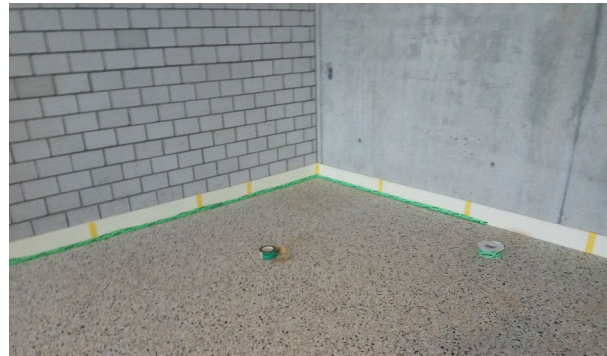
Randstellstreifen aus ISOPE umlaufend an der Wand verklebt
