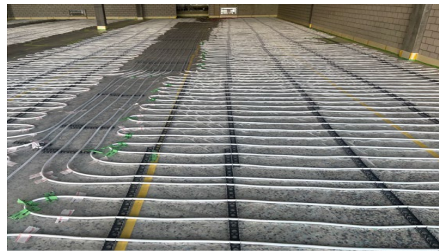
QS durch HBT-ISOL AG: Montagefläche kurz vor dem Einbringen des Unterlagsbodens
