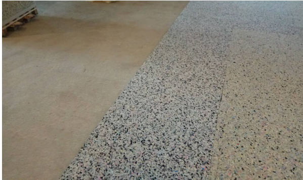
Vorbereitete und abgenommene Flächen mit verlegten ISO FLOOR®-Platten
