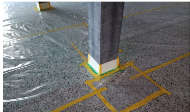
Umkleidete Stützen mit ISOPE Randstellstreifen zur Vermeidung von Körperschallbrücken
