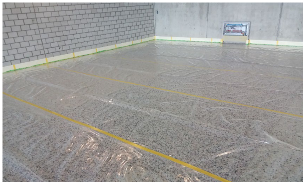
Mit ISO FLOOR® und PE-Folie bedeckte Fläche (bojakendichte Verklebung)
