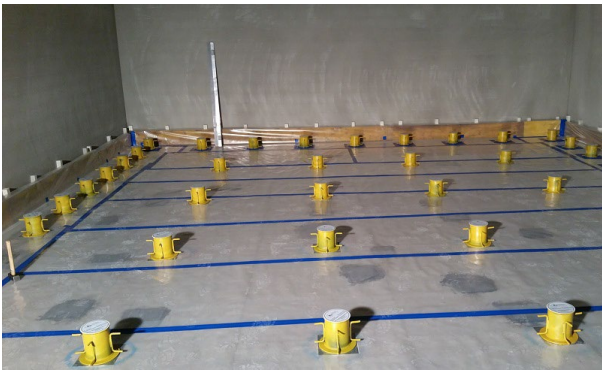
Versetzen der Gehäuse
