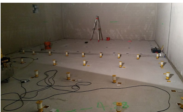
Einbau der Federelemente in die Gehäuse und hydraulisches Anheben der Beton-Lastverteilplatte
