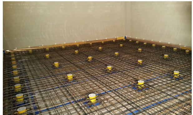
Bewehren der Lastverteilplatte vor dem Betonieren
