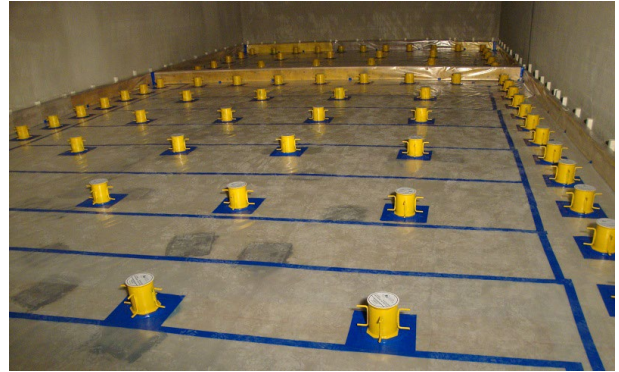
Versetzen der Gehäuse
