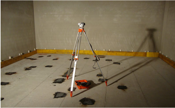
Einnivellieren der Federelemente
