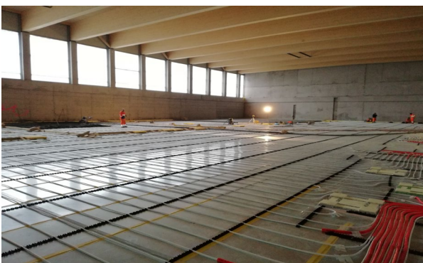
Die Bodenheizung wurde direkt auf die Stahlblechschalung verlegt.
