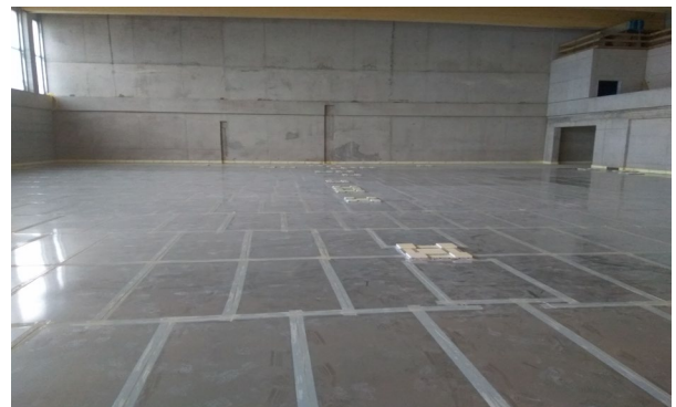
Über der Streifenlagerung verlegte verlorene Stahlblechschalung. Die Stösse wurden mit einem speziellen Klebeband bojakendicht abgeklebt.
