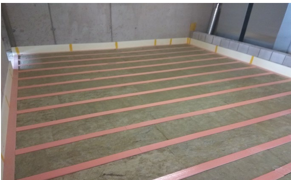
Die Geräteräume wurden ebenfalls mittels einer Streifenlagerung entkoppelt.
