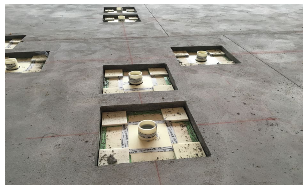
Eingebrachte Druckverteilterplatte mit gedämmten Bodenhülsen. Aufgrund der Aufbauhöhe wurden die Bereiche der Bodenhülsen nachträglich ausgegossen.
