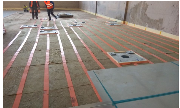
Gedämmte Bodenhülsen und Streifenlagerung aus ISOLMER® und ISOLMIN®.
