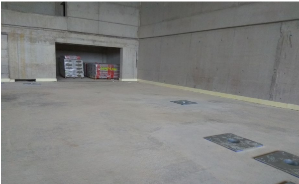
Sauber abtalschierte Betondecke. Als erstes wurden die elastisch gedämmten Bodenhülsen eingebaut.
