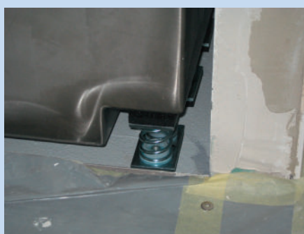
Blocs ressorts en acier ISOLASTIC pour l'amortissement des vibrations basse fréquence
