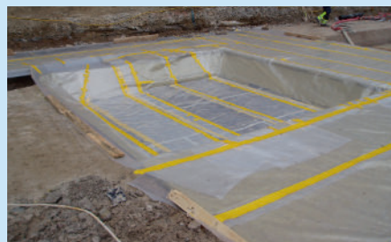
Revêtement terminé dans la zone de soutien y compris 2 couches de protection, collées de façon étanche, de feuille PE 0,2 mm
