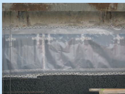
Montage du revêtement isolant vertical de type ISOPOL-HT-15, 2 couches, épaisseur de 30 mm. Protection du revêtement par 2 feuilles en PE 0,2 mm.
