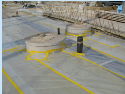
Découpes et raccords dans la zone des puits
