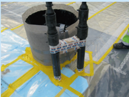
Coupe précise du revêtement et de la laine minérale. Ici, dans la zone du répartiteur des sondes de terre
