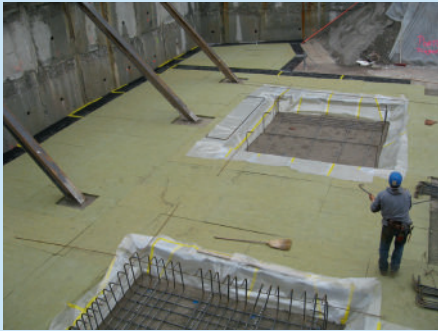
Semelle de fondation bétonnée. Plaques en fibres minérales posées dans la zone de la surface
