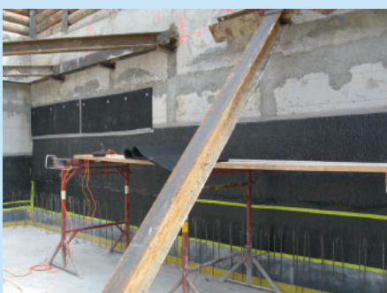
Montage du revêtement isolant vertical de type ISOPOL-HT-15, 2 couches, épaisseur de 30 mm. Protection du revêtement par 2 feuilles en PE 0,2 mm.
