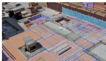
Neufrankengasse, Zurich : appuis en ISOLMER® dans la zone des fondations, des dalles et des murs.
