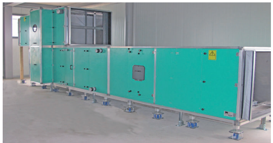
Les 60 installations monoblocs ont été fixées et isolées contre les vibrations à l'aide de 530 paquets de ressorts ISOFED et ISOROHR.
