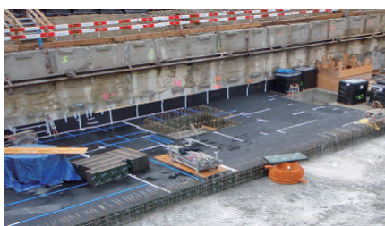
Swissmedic Berne : appui ISOPOL®-posé dans la zone des dalles et des fondations.
