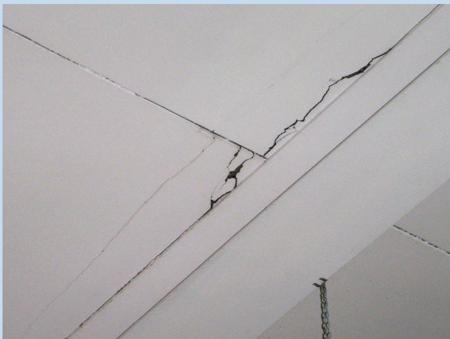
Etat de la dalle avant les travaux d'amortissement
