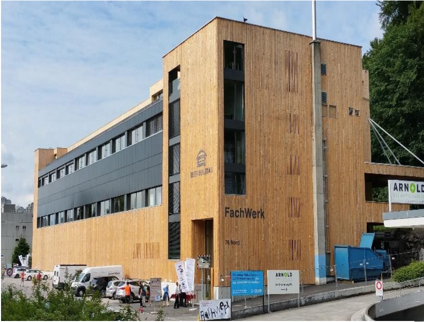
Fachwerk der Firma Beer Holzbau AG mit einer Mischung zwischen Produktion, Büro und Wohnen
