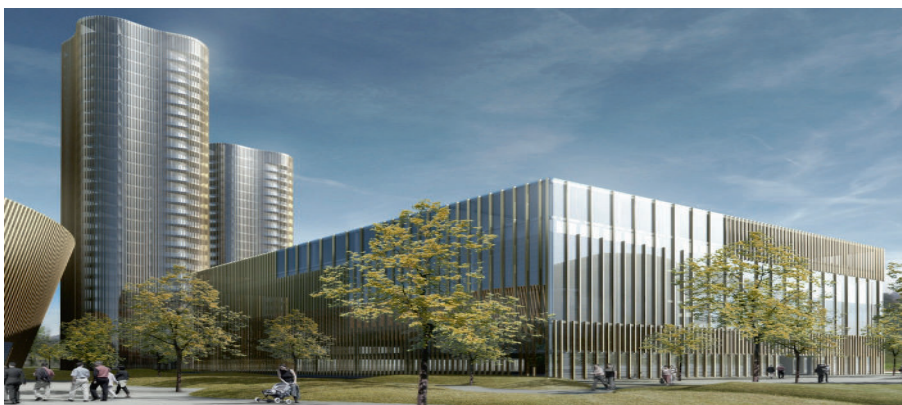
La Sportarena Allmend abrite à la fois des salles de sport et des bureaux grâce au système de découplage acoustique prouvé HBT-ISOL
