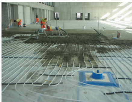
Coulage de la sous-couche en béton dur avec adjonction de ciment spécial sur l'appui posé et contrôlé
