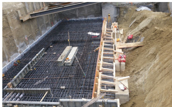
Etappe 1 der fertig armierten Bodenplatte. Vor dem Betonieren wird der Lagerschutz auf eventuelle Fehlstellen kontrolliert und wenn nötig ausgebessert.
