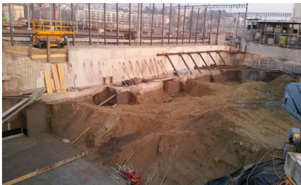
Bausituation mit Baugrubenaushub. Längs zum Gebäude die Bahnlinie, zu welcher das Gebäude mittels dauer-elastischen Elastomerkormmatten entkoppelt wurde.
