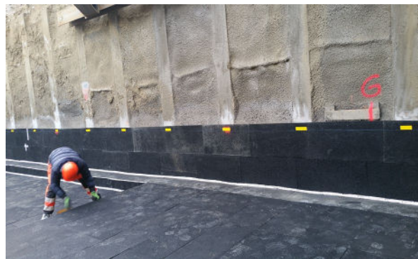
Montage und exaktes Einpassen der horizontalen und vertikalen Elastomerkormmatten ISOPOL® im Bereich der Bodenplatte.
