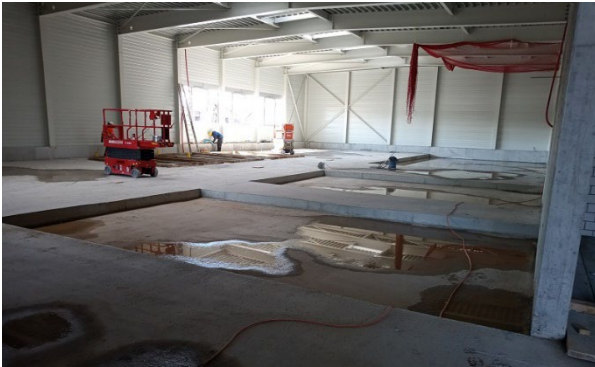
Rohdecke der Werkstatt bzw. der Spenglerei, vorbereitet für das Verlegen der Dämmmatten
