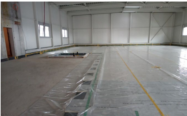
Zu lagernde Fläche komplett verlegt und mit Folie geschützt
