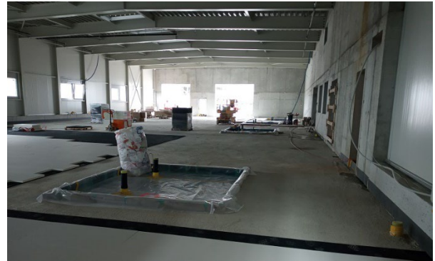
Teilweises verlegtes ISOPOL® und Wärmedämmung
