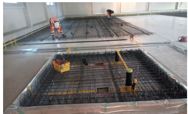
Zug-um-Zug folgt im Anschluss der Eisenleger mit den Bewehrungsarbeiten
