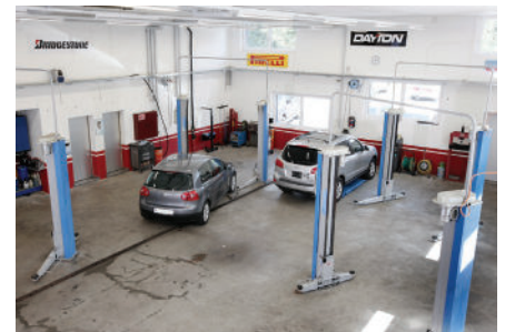
L'utilisation des lifts et autres installations cause des vibrations et des bruits solidiens qui sont perçus comme nuisances dans les appartements.
