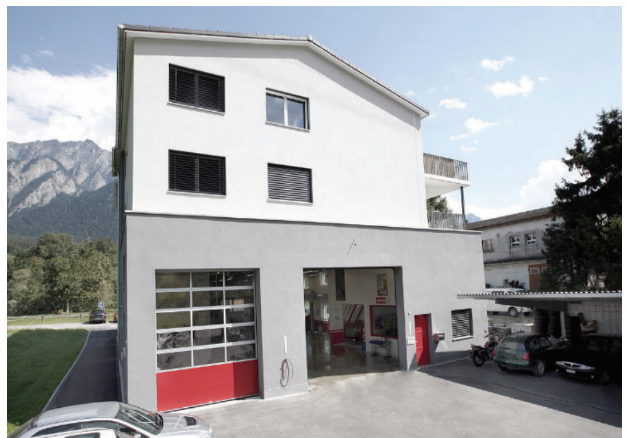
Les utilisations mixtes sont de plus en plus courantes. Elles exigent des mesures de protection acoustique spécifiques.
