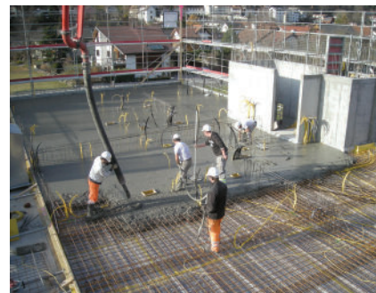
Le bétonnage de la dalle sur l'appui isolant. Sur cette dalle, la partie habitable sera construite en technique conventionnelle.
