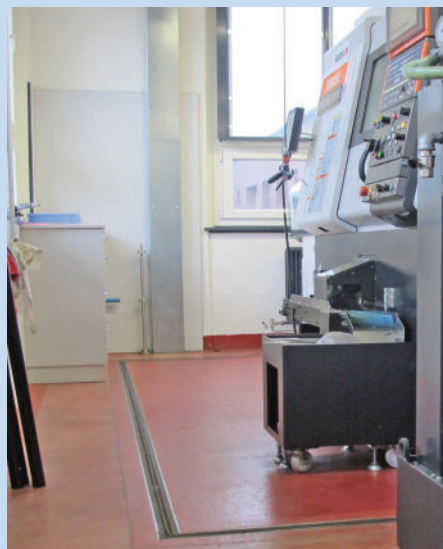
Le recouvrement définitif du joint de séparation entre la dalle de fondation du centre d'usinage et la dalle existante
