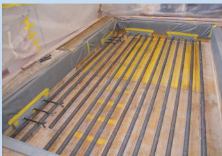
La découpe dans la dalle avec le nouveau coffrage prêt au bétonnage
