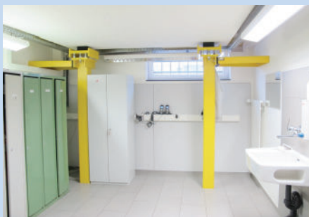
Les piliers dans le local sous la machine. En tête des piliers, les appuis en élastomère
