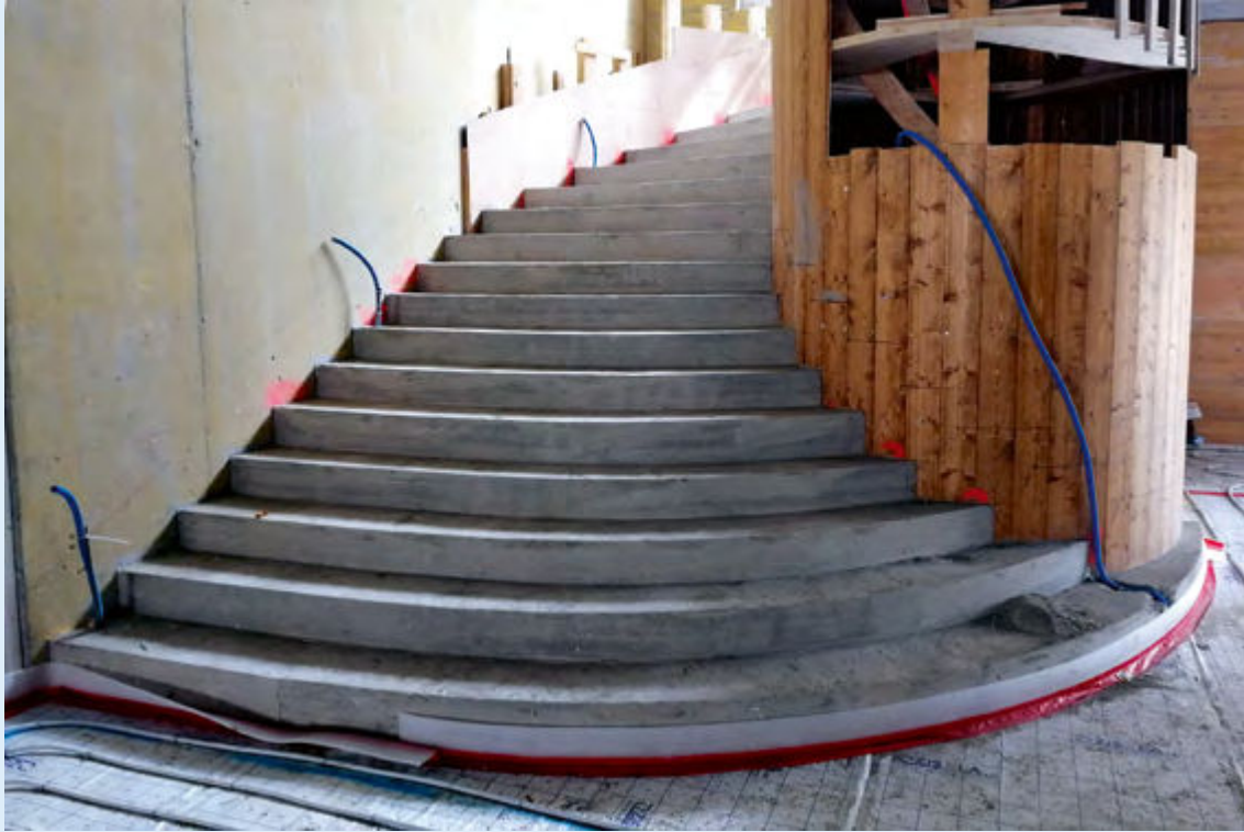
Fertig betonierte Treppe
