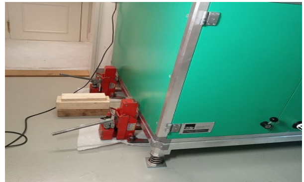
Absenken der Anlage und kontrollieren der Einfederung
