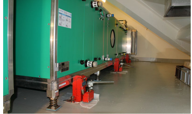
Anheben der Anlage mittels Hydraulikhebern
