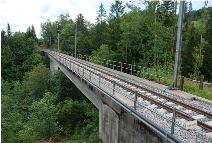
Kaubachbrücke, Gonten: Schotterschonung mittels Unterschottermatten
