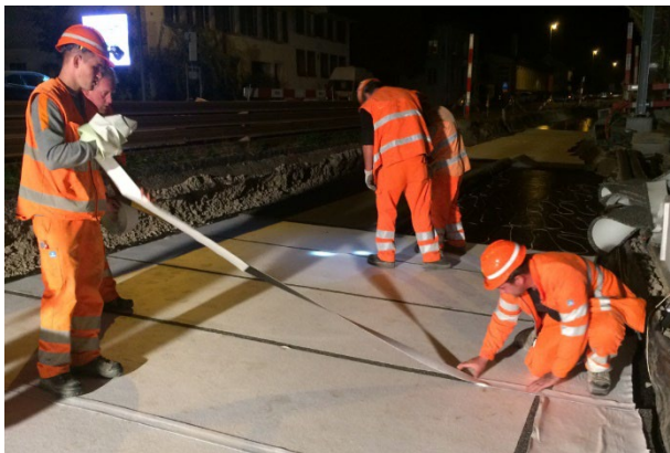
Abdichten und Verbinden der Mattenstösse mit einem schutzvlies-kaschierten Abdeckband von sehr hoher Klebkraft.
