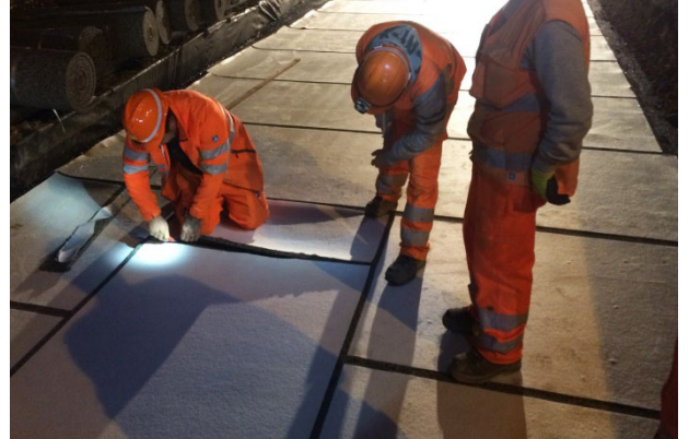
Einmessen, Zuschneiden und Einpassen der Matten in der konischen Fläche des Weichenbereiches.
