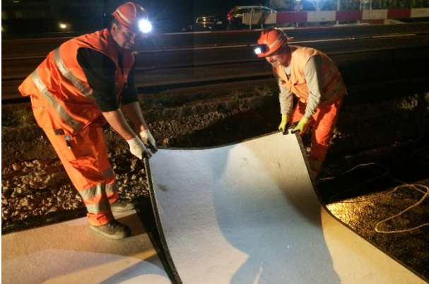
Verlegen der Unterschottermatten HBT SBM K 20V während der Totalsperrung in der zweiten Bauphase. Die Matten sind werkseitig mit einem Schutzvlies kaschiert.
