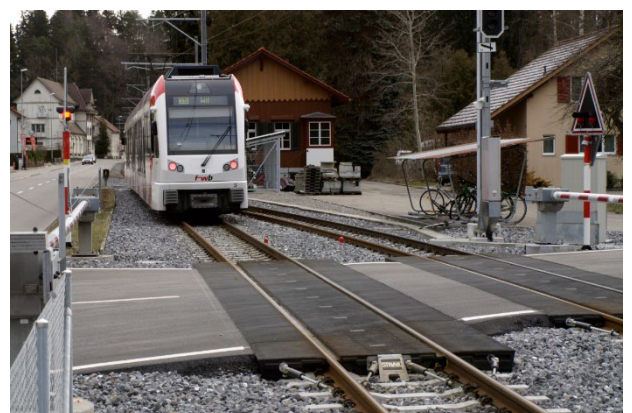
Die Bahn verkehrt wieder fahrplanmässig. Ebenso erfüllt die Unterschottermatte in den angrenzenden Gebäuden den geforderten Schutz gegen Körperschall und Erschütterungen.
