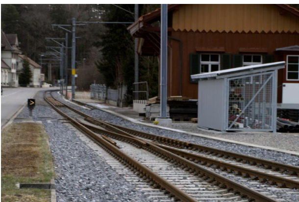
Der Gleisoberbau bestehend aus Gleisschotter, Betonschwellen, Geleisen und Weiche ist erneuert.
