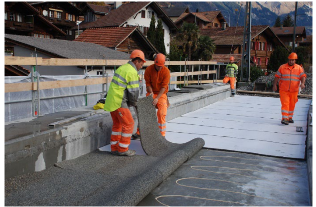
Verlegen der horizontalen Unterschottermatten. Die Matten werden gegen den Untergrund verklebt, sodass sie mit leichten Pneufahrzeugen befahrbar sind.
