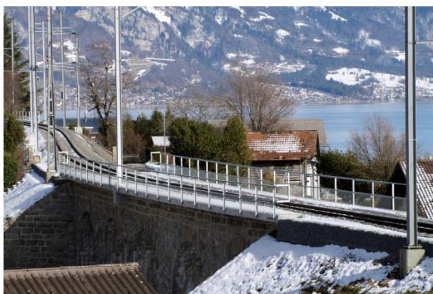
Fertig saniertes Viadukt mit dem betonierten Trog, dem erneuerten Gleisoberbau und der Fahrleitung.
