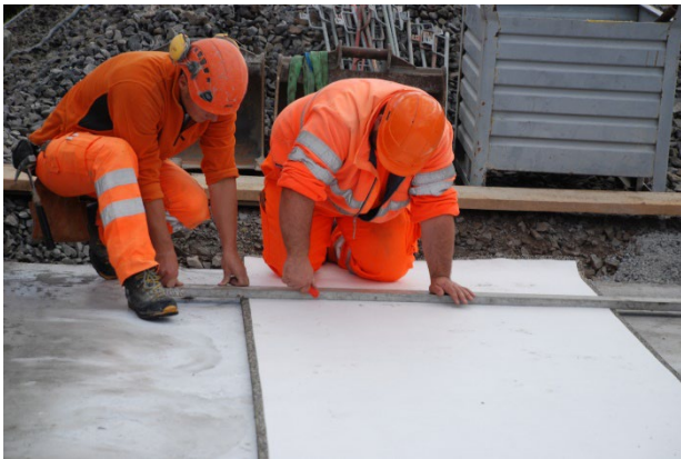
Einmessen der Unterschottermatten HBT SBM K 20V. Die Matten lassen sich mit einem Teppichmesser einfach zuschneiden.
