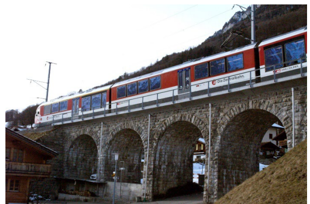
Die Bahn verkehrt wieder und die eingebauten Unterschottermatten schützen die Kunstbauten und sorgen für eine gleichmässige Beanspruchung des Schotter.
