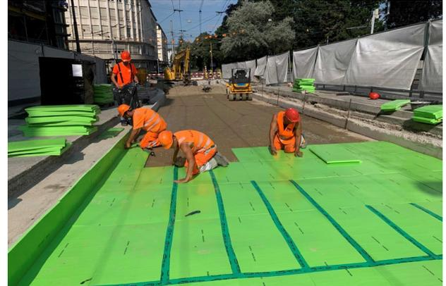
Die Betonplatte des Tramtroges wird auf Dämm-Matten Typ ISOLMER® elastisch gelagert. Die Matten werden satt gestossen auf die Planie des Unterbaus verlegt bzw. vertikal an den Negativbeton und die Abschalungen angeklebt.
