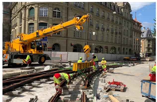
Versetzen und Ausrichten der Geleise auf dem Schutzbeton über den ISOLMER® Dämm-Matten. In einem nächsten Schritt konnte der Tramtroge ausbetoniert werden.
