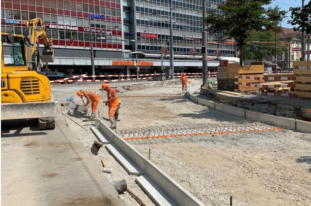
Vorbereiten des Unterbaus und der Abschalungen. Die Beton-Dehnungsriegel zur Fixierung des Gleistroges im Kurvenbereich wurden mit Dämm-Matten vom Typ ISOLDYN® entkoppelt.
