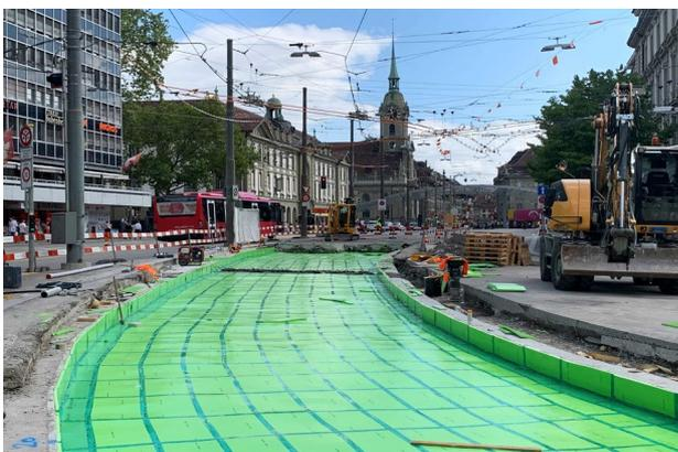
Fertig verlegte horizontale und vertikale Dämm-Matten ISOLMER®. Auf die Matten wurde unmittelbar nach der Montage ein Schutzbeton eingebracht.
