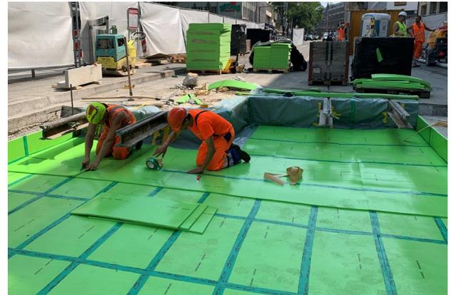
Die Dämm-Matten wurden nahtlos an die Dämmung unter den bestehenden Tramtrögen geführt. Die Steifigkeit der Matten im Übergangsbereich zwischen dem neuen Masse-Feder-System und den bestehenden Tramtrögen wurde spezifisch abgestimmt.
