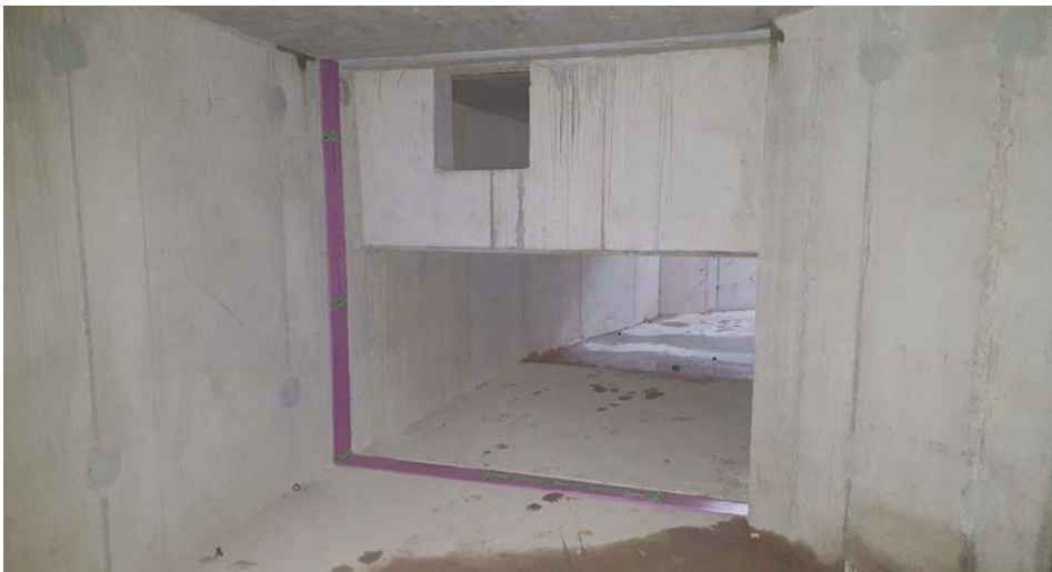
Abb. 13: Abdichtung des Unterwasserkanales
