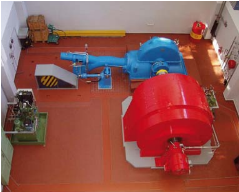
Abb. 1: Die alte Anlage des Kraftwerkes Chapfensee-Plons in der Schweiz vor der Sanierung [4]
