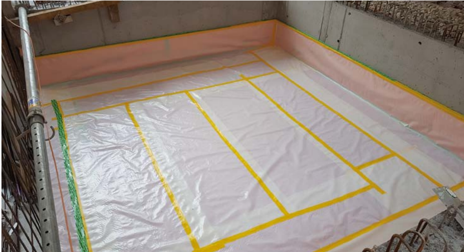
Abb. 10: Lagerebene Generator-Fundament, abgedeckt mit zwei Lagen PE-Folie
