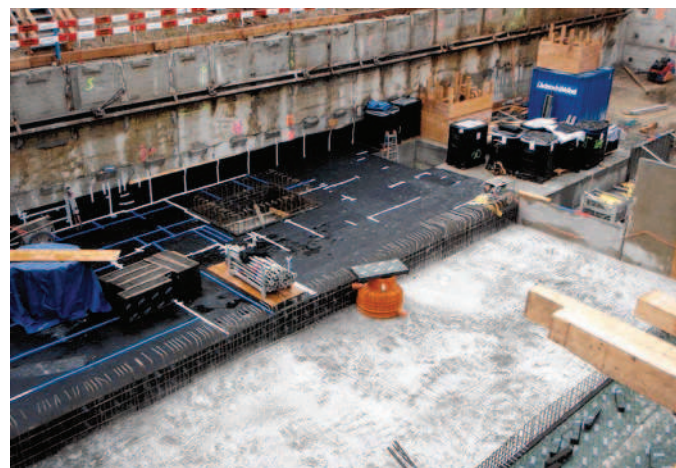
Swissmedic Bern. Verlegte ISOPOL®-Lagerung im Bereich der Bodenplatte und Fundamente.
