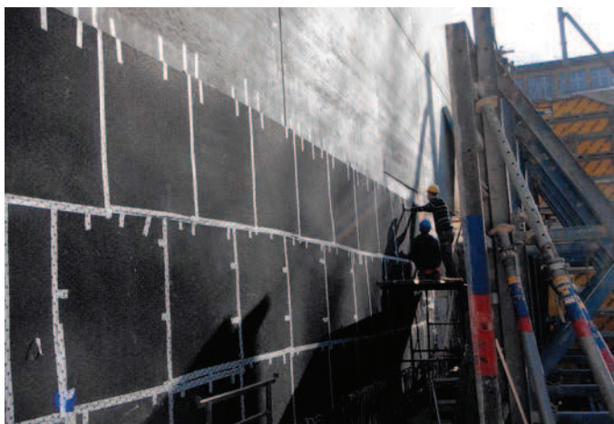
Swissmedic Bern. Montage der ISOPOL®-Lagerung im Wandbereich.
