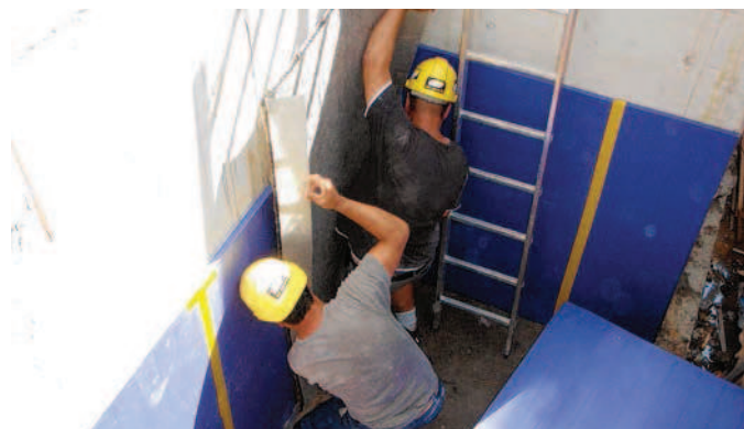
Neufrankengasse Zürich: Montage der ISOLMER®-Lagerung im Wandbereich inklusive Lagerschutz ISODRAIN.
