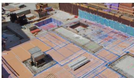
Neufrankengasse, Zürich. ISOLMER®-Lagerung im Bereich Fundamente, Bodenplatte und Wände.
