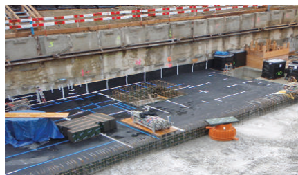
Swissmedic Bern. Verlegte ISOPOL®-Lagerung im Bereich der Bodenplatte und Fundamente.
