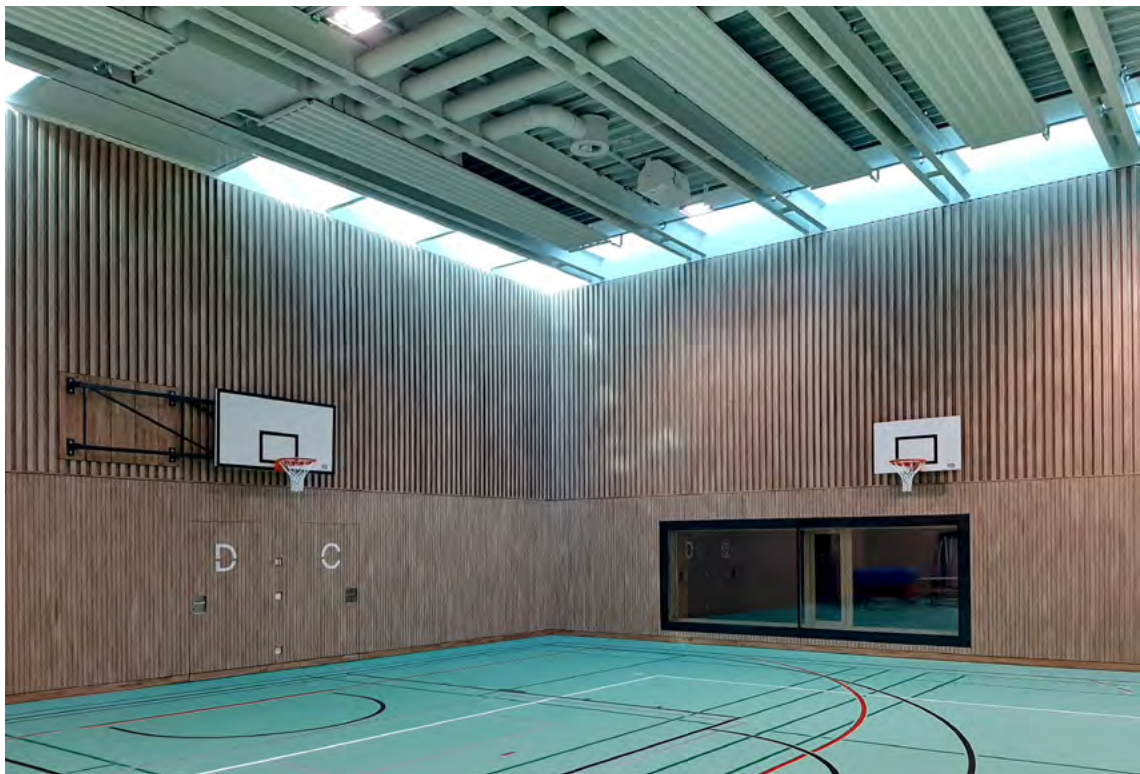
Vorsatzschalen in Holzbauweise
