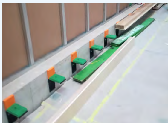
Körperschalldämmende Auflager für die Befestigung der Festverglasung
