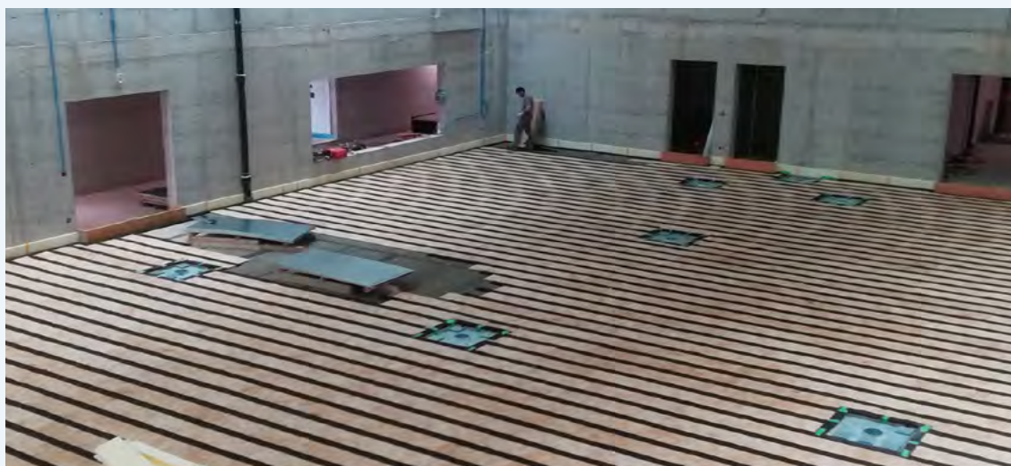
Streifenlagerung aus ISOLMER® mit Hohlraumbedämpfung, ISOLMIN® und Bodenhülsen.
