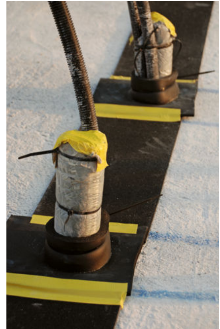
Rohrdurchbrüche im Bereich des ISONOVA® Akustik-Trennlagers mit ISOLINE-SPEEDY ummantelt
