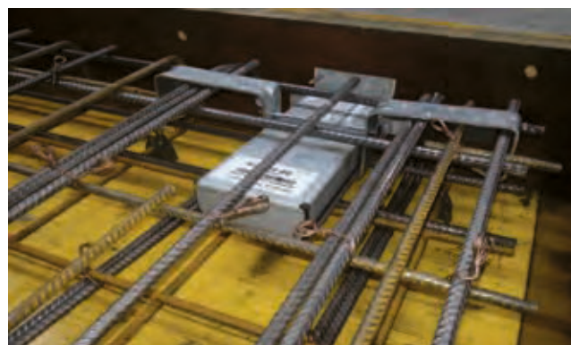
Confection d'éléments préfabriqués: ELBOX-60 avec son étrier d'armature fixé contre le coffrage d'un élément de palier préfabriqué. Les éléments étant toujours bétonnés «à l'envers», l'ELBOX et l'étrier d'armature sont montés retournés de 180°.
