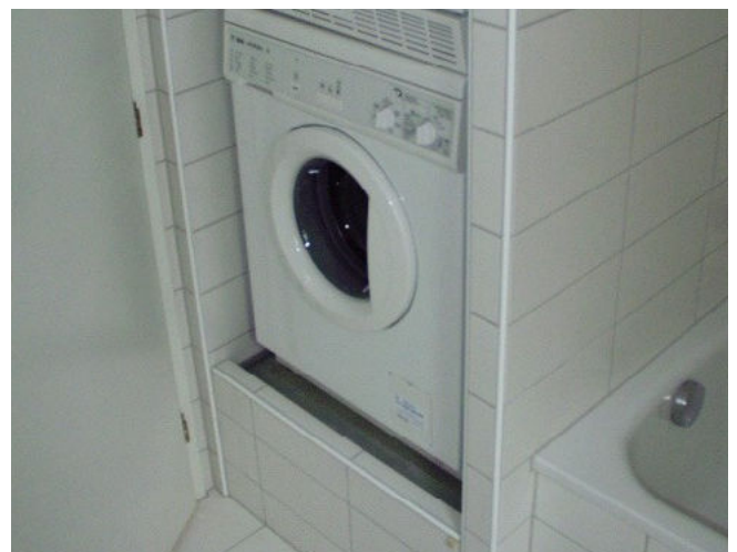
Altbautausanierung mit Lagerung der Waschtürme auf ISOWAMA-FED-W
