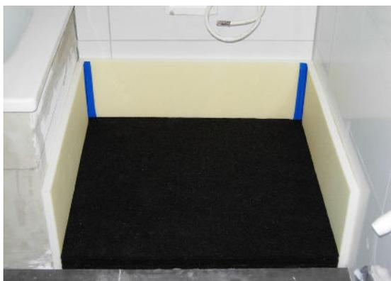
**3** Die ISOPOL-Matte wird 2-lagig vollflächig, mit der Profilierung nach unten, verlegt.
