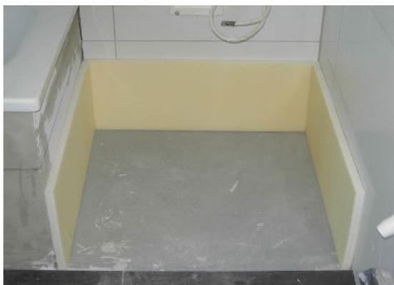
**2** Auf der Baustelle werden zuerst die zur Lagerung angrenzenden Wände mit dem mitgelieferten ISOPE ausgekleidet.
