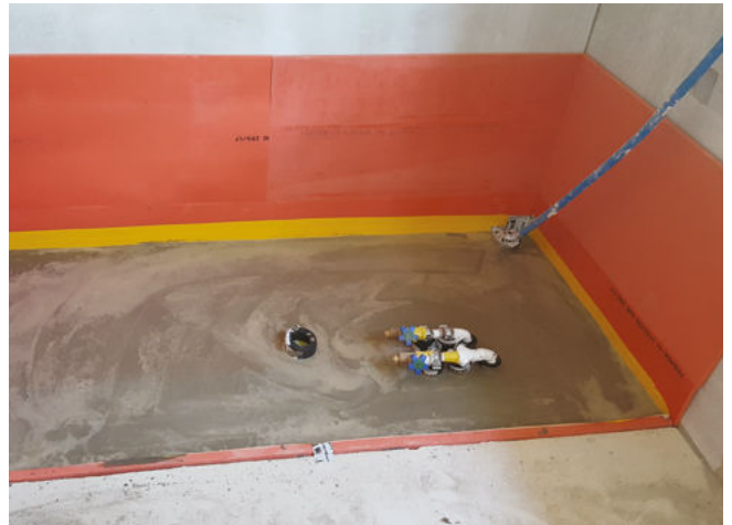
Rechteck-Wanne: frisch betoniertes, gelagertes Massefundament
