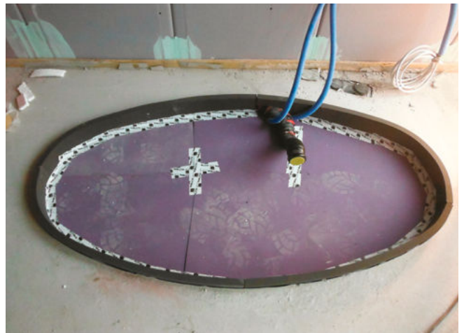
Oval-Wanne: montierte Lagerung mit Randstellstreifen vor dem Isolieren der Leitungen
