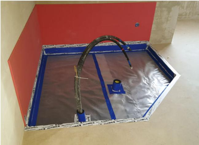
Baignoire à angle: isolation acoustique posée avec séparation souple contre dalle, parois et conduites
