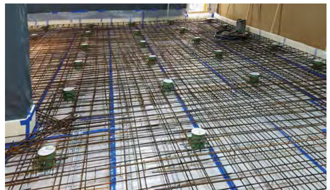
Pose de l'armature et contrôle de l'ensemble de l'appui par HBT-ISOL pour détecter d'éventuels défauts
