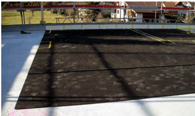
Appui en ISOPOL® sur toute la surface, adapté à la charge, nattes posées directement sur la dalle en béton au-dessus du garage
