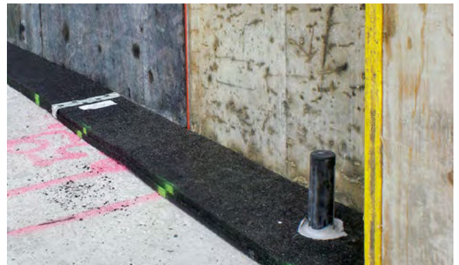
Appuis linéaires ISOPOL® et ISOLMER® posés et adaptés aux charges
