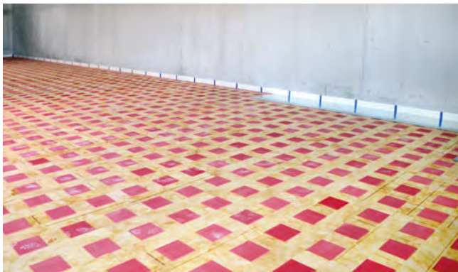
Pose de points ISOLMER® avec amortissement des cavités et bandes de rive en ISOPE
