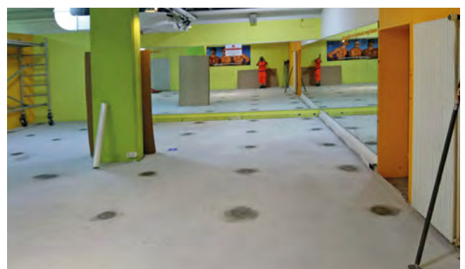
Les éléments à ressorts ISOMATIC-G sont installés et compressés. Le revêtement de sol et les équipements de fitness peuvent être installés
