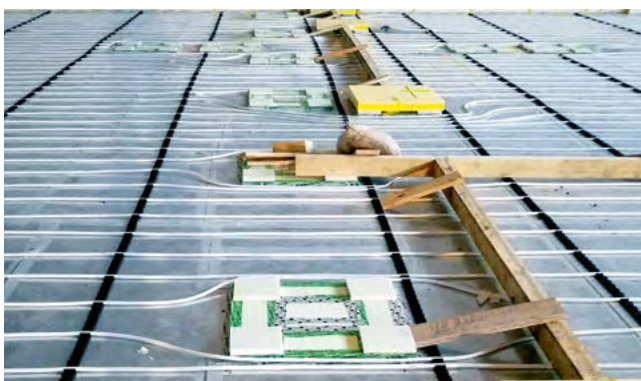
Découplage acoustique de toutes les douilles de fixation au sol des engins de sport
