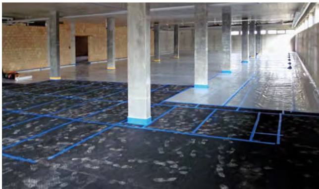
Surface totale en ISOPOL® et protection de l'appui par feuilles en PE
