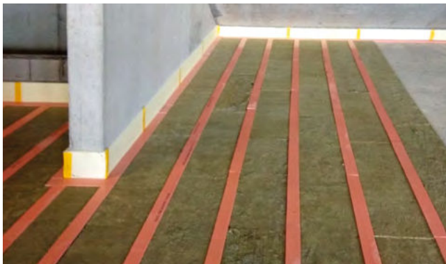
Appui avec bandes ISOLMER® posées sur la dalle de plafond au-dessus des salles de classe et amortissement des cavités entre les bandes porteuses
