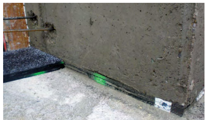
Mur en béton apparent avec exécution professionnelle du joint dans la zone d'isolation entre le mur et le plafond au-dessus du niveau des magasins
