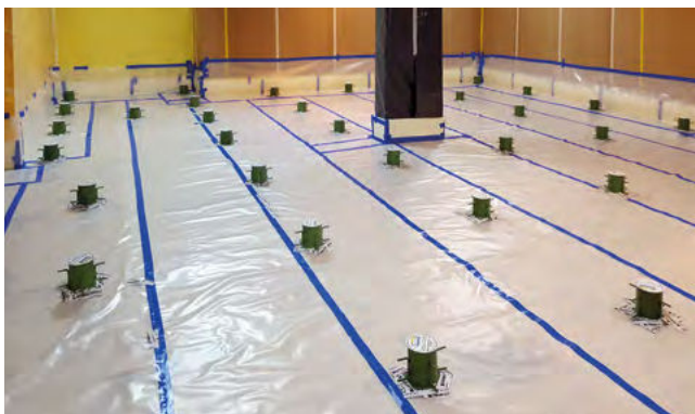
Ressorts ISOMATIC-G posés sur une feuille PE
