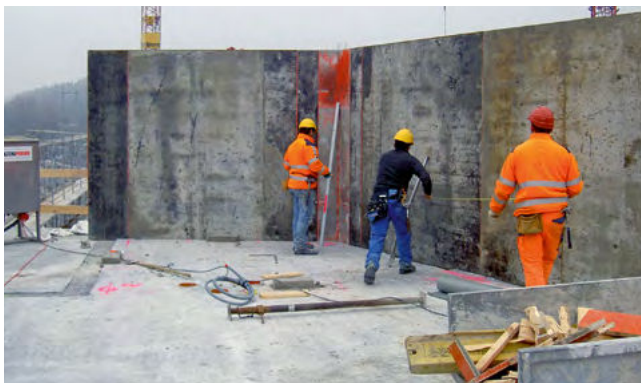
Mise en place du coffrage des murs côté extérieur
