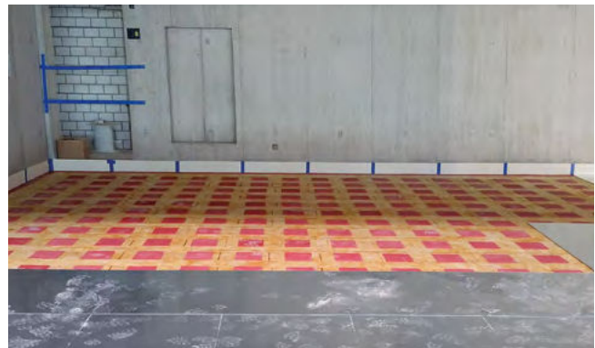
Recouvrement de l'appui par un coffrage perdu en tôle
