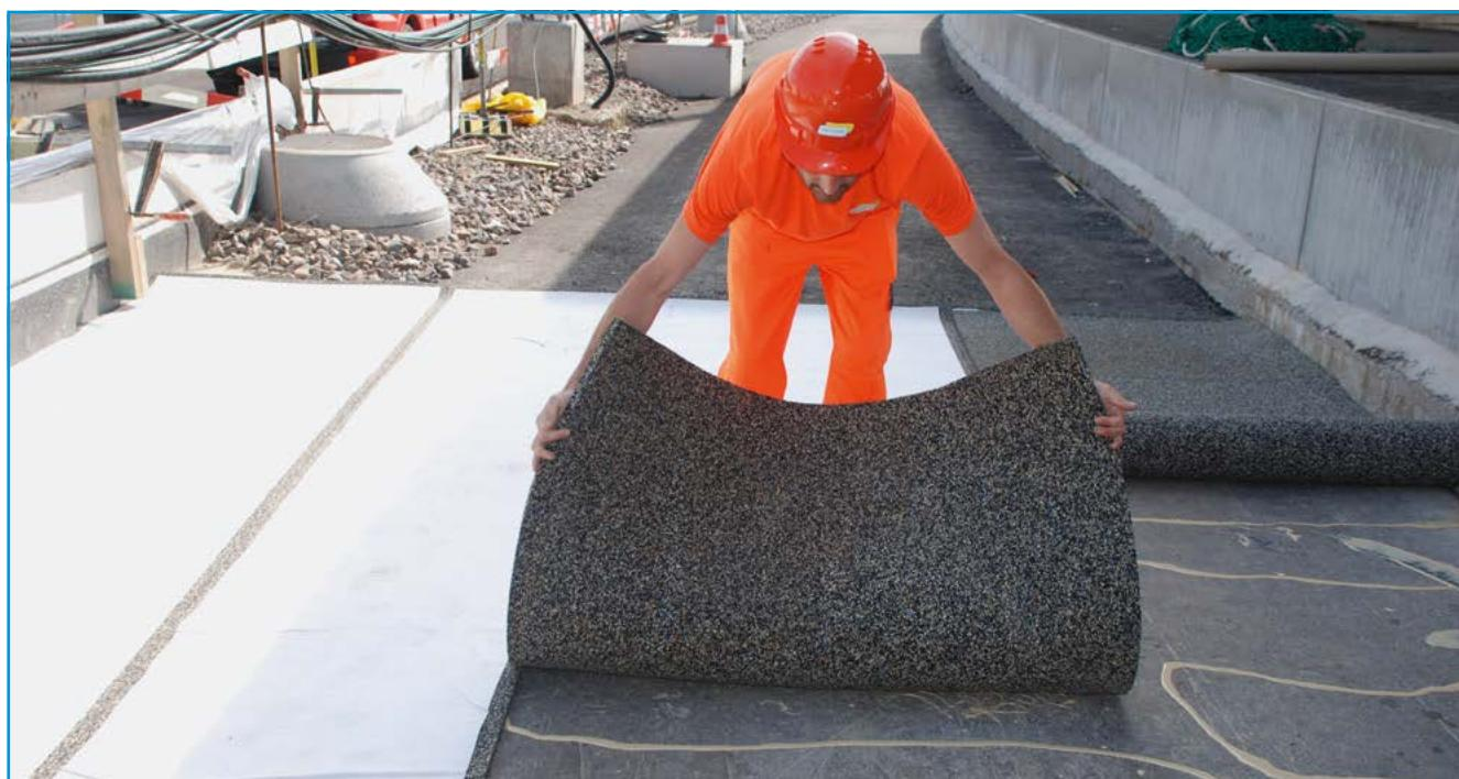
Situation de montage de l'appui élastique dans l'auge
