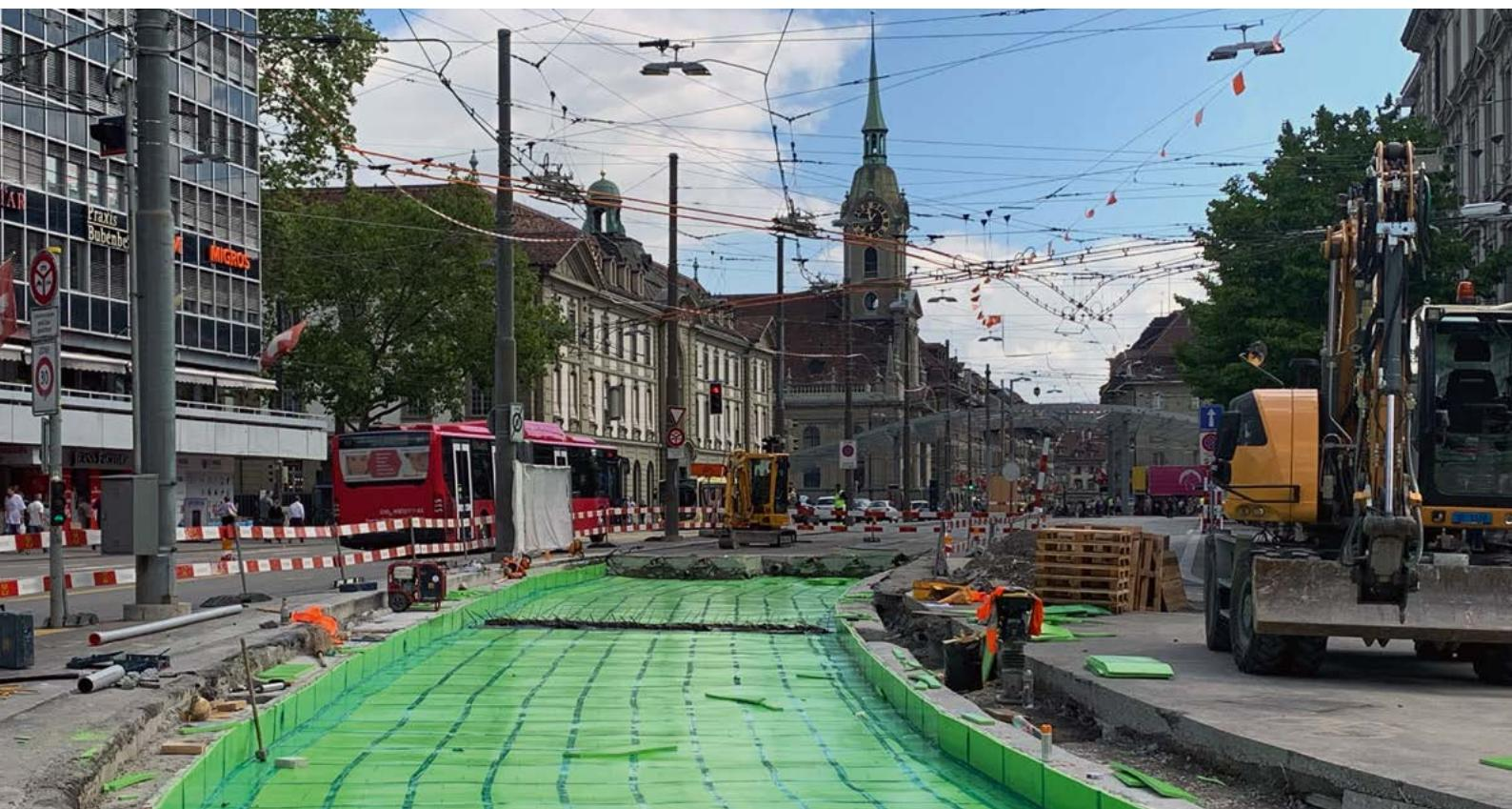
Masse-Feder-System mit Dämmmatten ISORAIL® MMS P in PUR-Qualität
