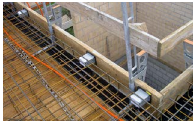
Bétonnage sur place: Les boîtiers isolants acoustiques ISOLA® 35 dB sont montés dans la bonne direction dans le coffrage du noyau de la cage d'escalier, prêts à être bétonnés dans la dalle.
